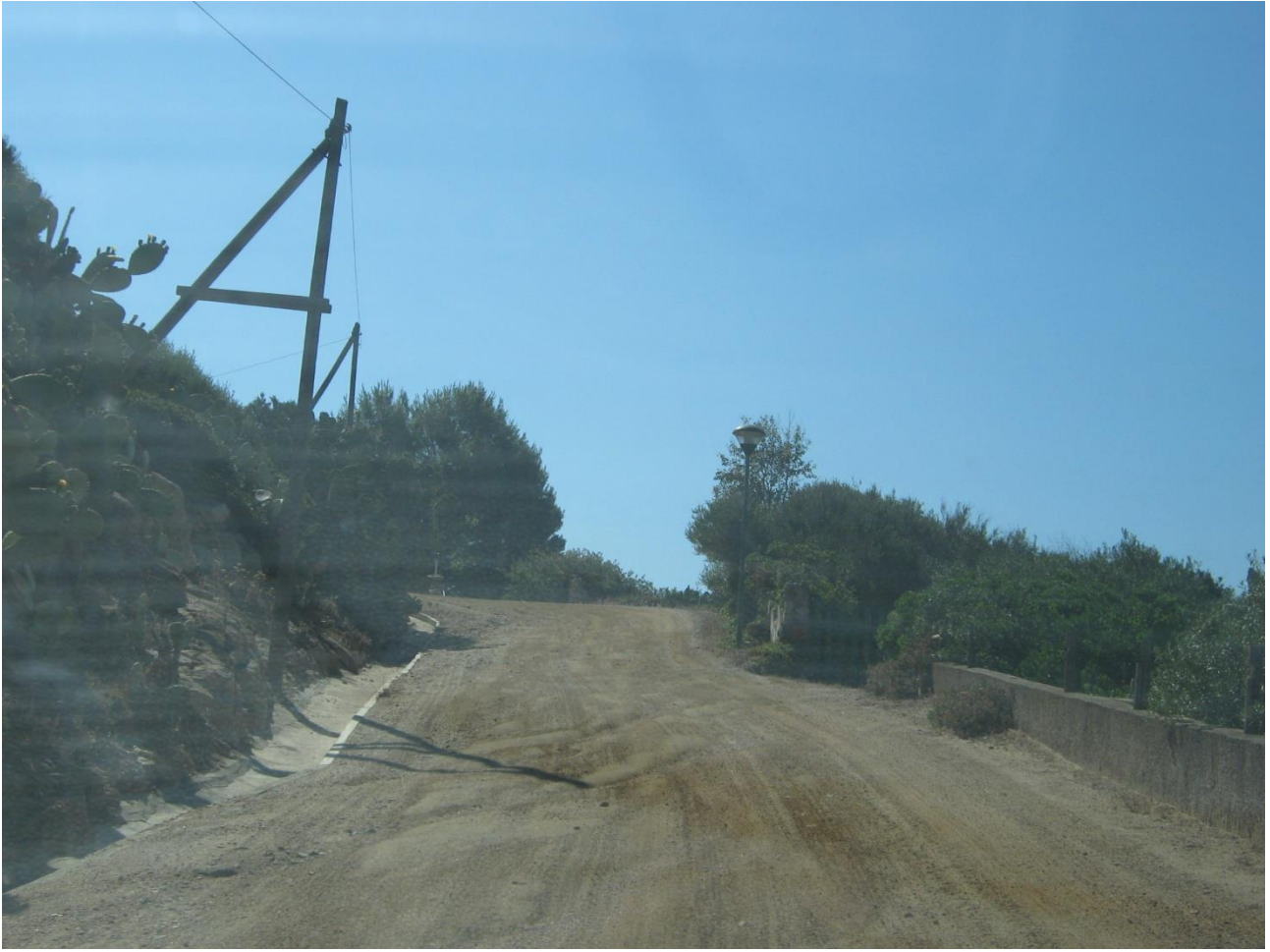
Via Croce del sud: tratto in acclività con cunetta laterale parte in cls e parte in terra.
