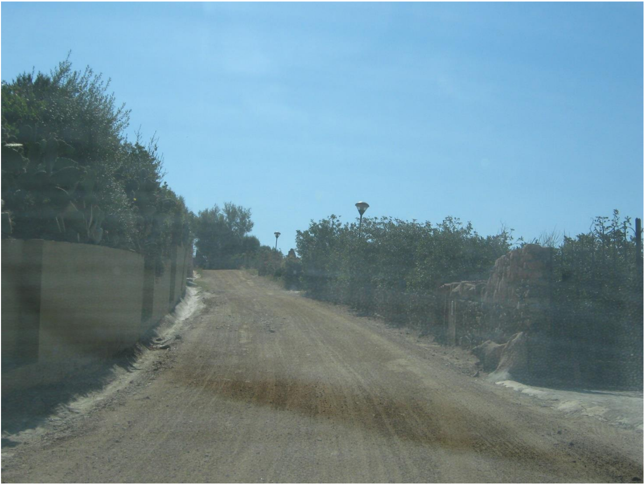
Via Croce del sud: tratto in acclività con cunetta laterale.
