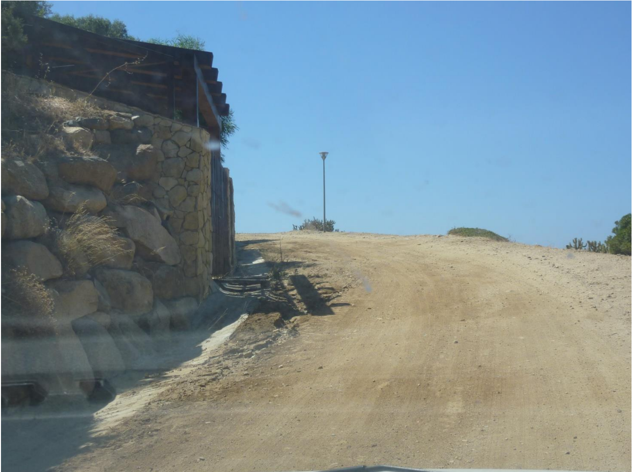
Via Gemma: tratto in acclività danneggiato con cunetta laterale in cls.
