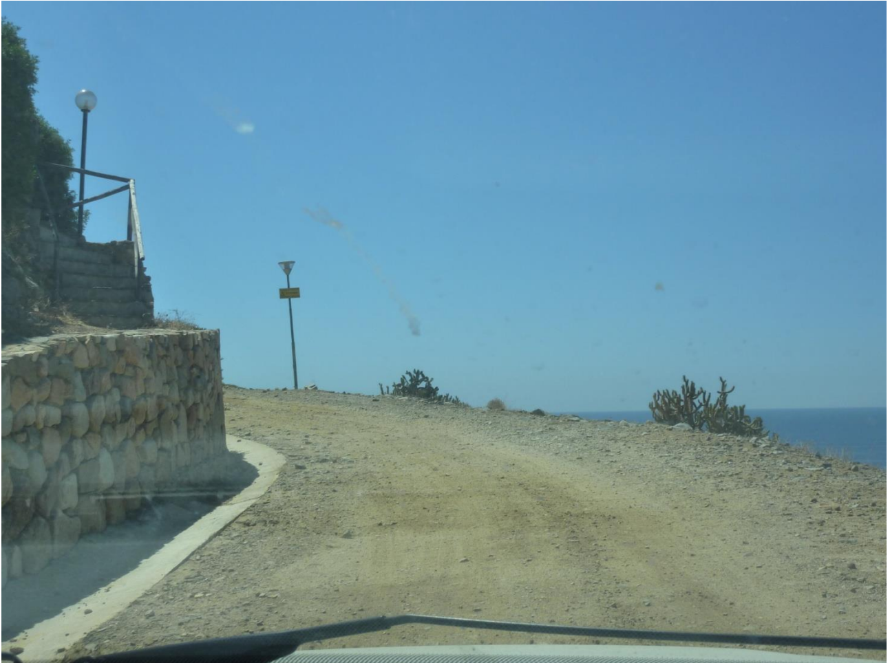
Via Gemma: tratto in acclività su scarpata con cunetta laterale in cls.
