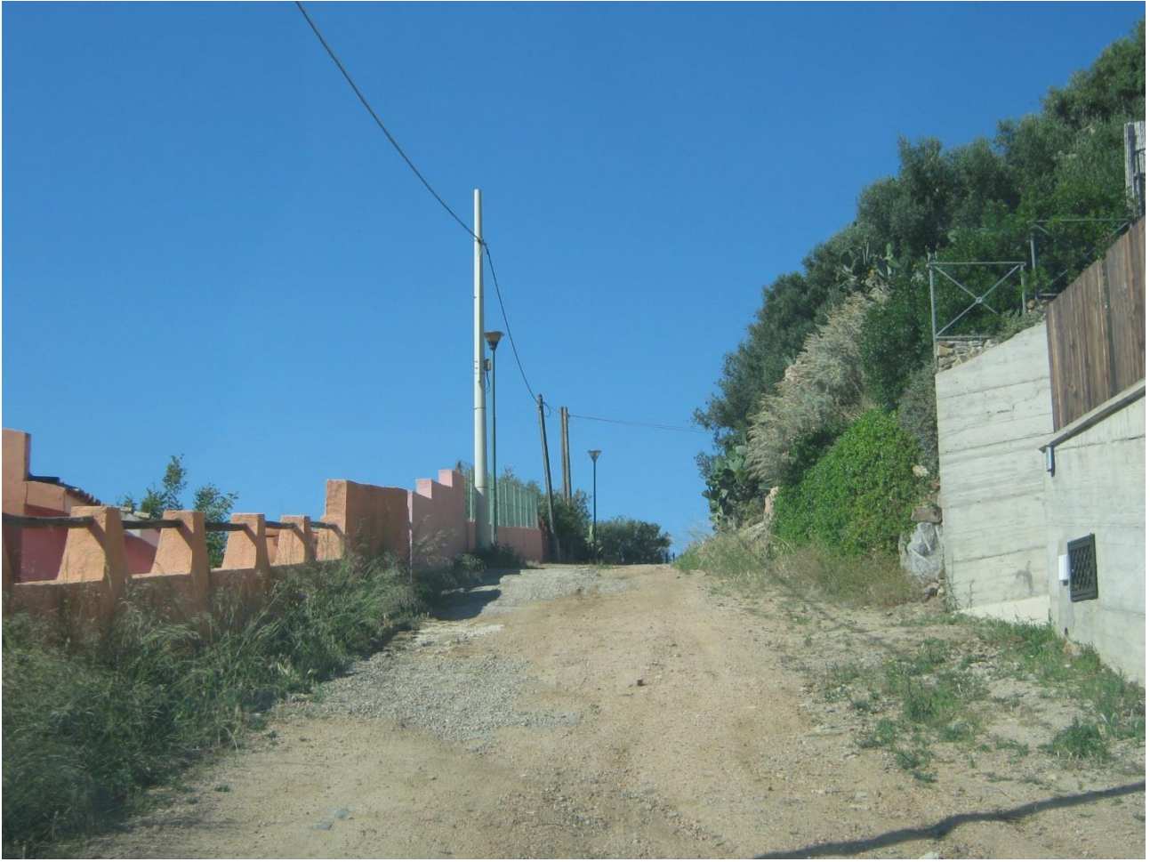
Via Croce del sud: tratto in acclività con banchine erbose da sfalciare.
