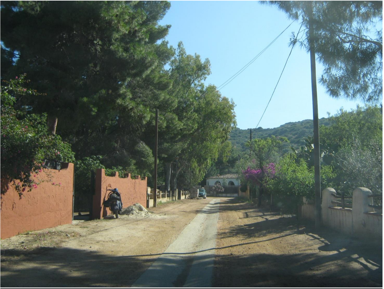
Via dell'Alcione: cunetta centrale in cls
