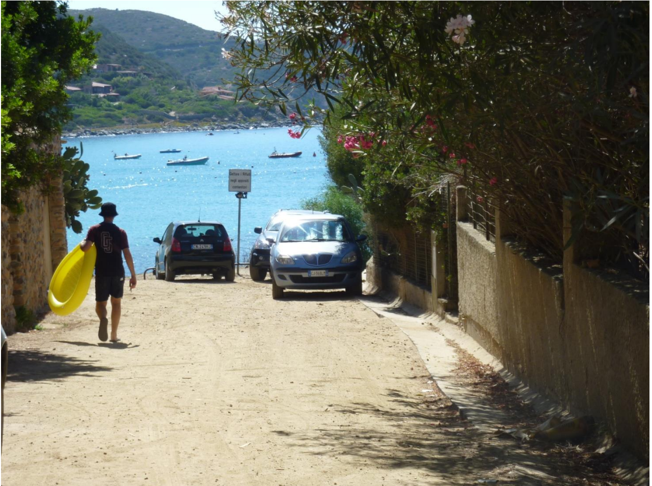
Via Vega: tratto sterrato con cunetta laterale in cls
