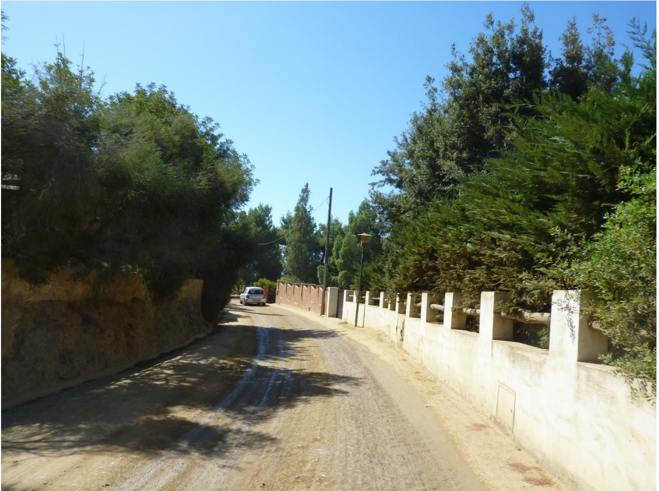
Via del Sagittario: tratto pianeggiante con cunetta in cls laterale e recinzioni.
