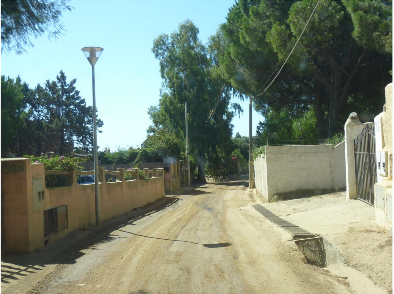
Via Urano: tratto con cunetta laterale in terra.
