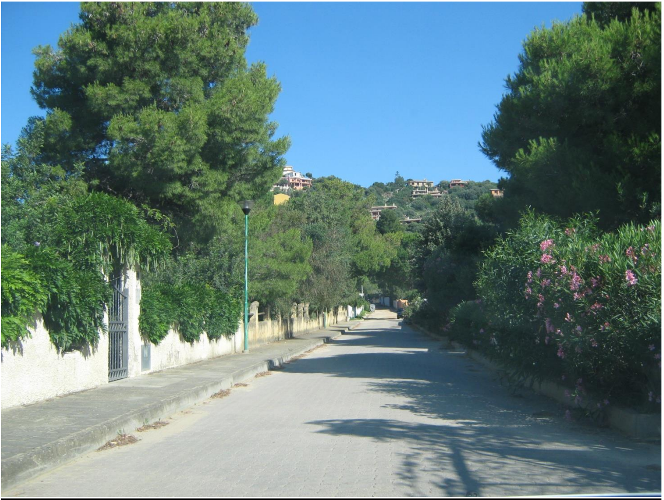
Via dell'Acquario: tratto pavimentato in autobloccanti di cls, con marciapiedi e aiuole laterali.
