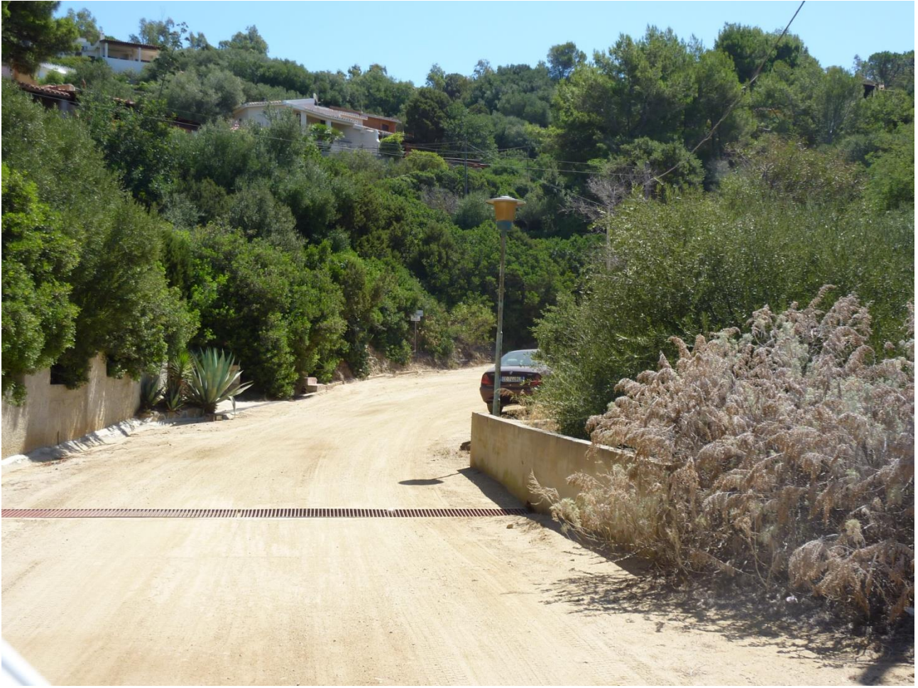
Via Gemma: Tratto con caditoia trasversale e cunetta laterale in cls.
