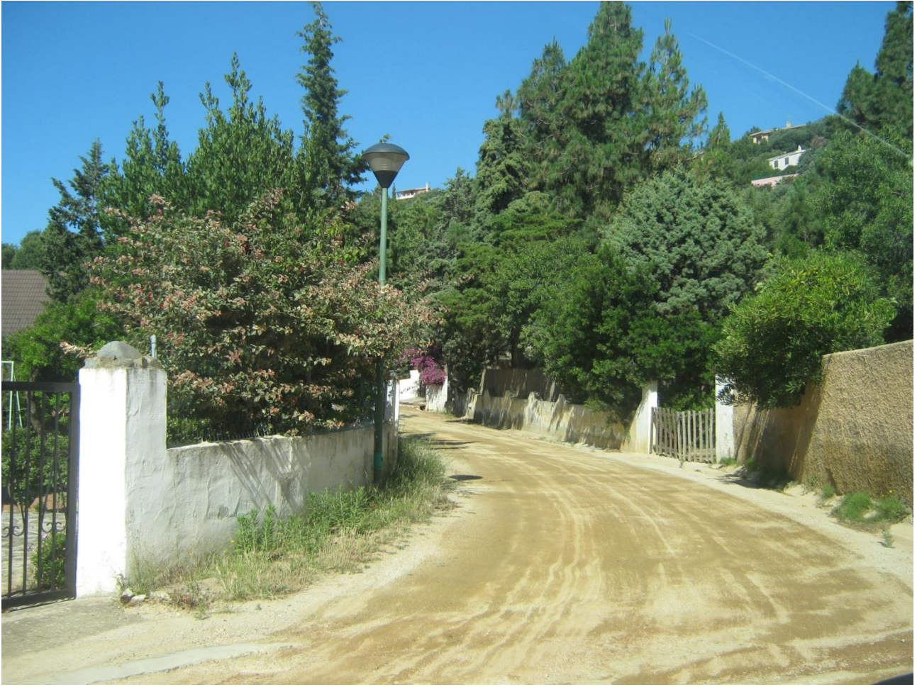
Via Croce del sud: tratto con banchine erbose e cunetta laterale.
