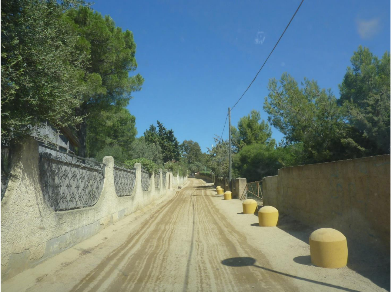
Via Urano: tratto tra muri di recinzione
