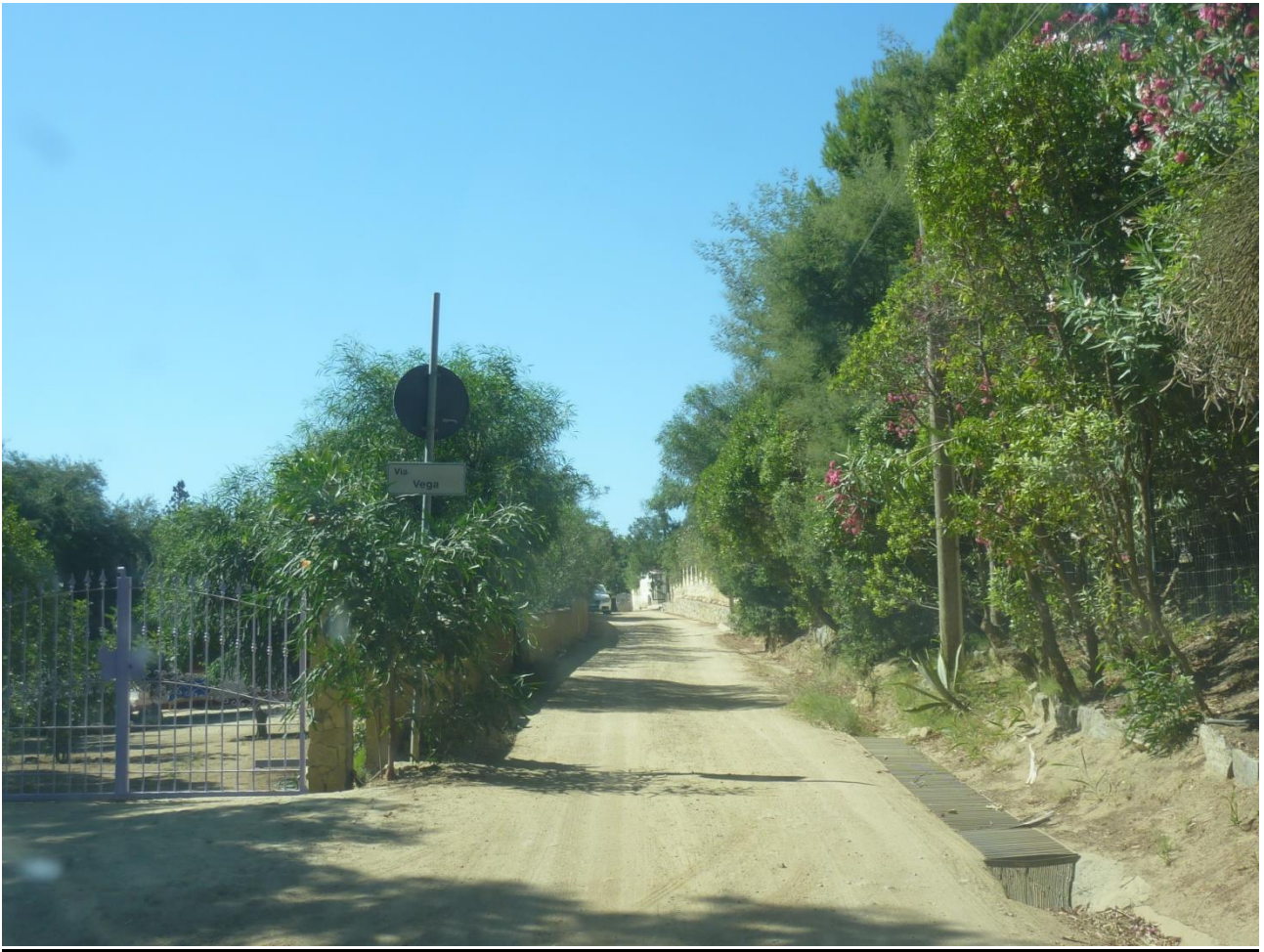
Via Vega: tratto sterrato con cunetta laterale parzialmente in cls
