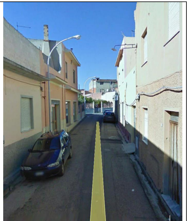
02) Stradale non conforme alle linee guida regionali
