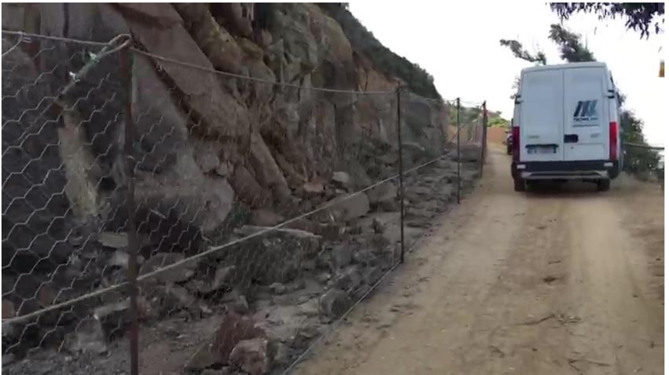
Figura 12. Una parte dei depositi rocciosi del disaggio.
