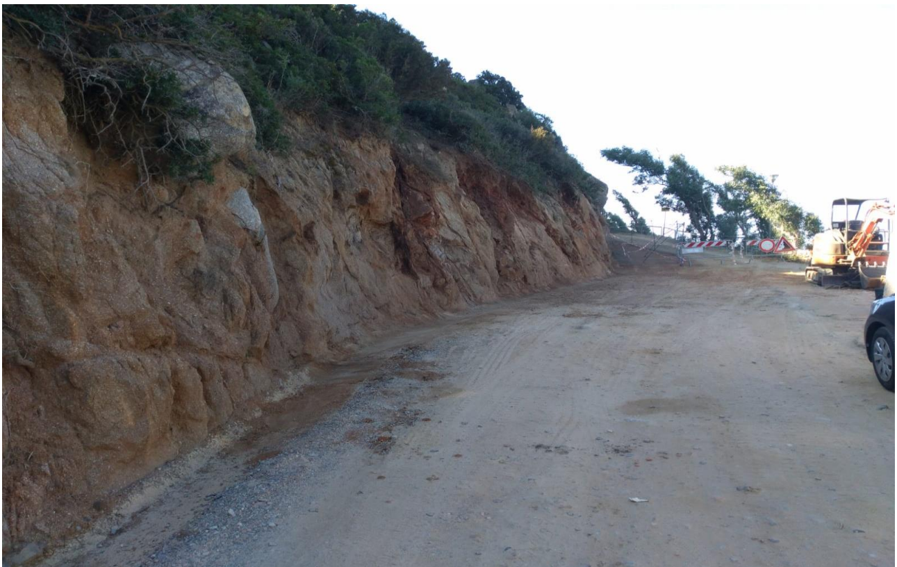
Figura 14. Post intervento di messa in sicurezza del costone roccioso.
