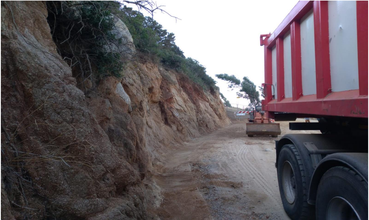
Figura 13. Post intervento di messa in sicurezza del costone roccioso.
